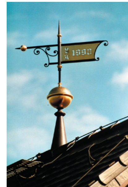
Carport bei Wurzen Entwurf, Herstellung und Montage der vergoldeten Wetterfahne mit Kugel aus Kupfer
