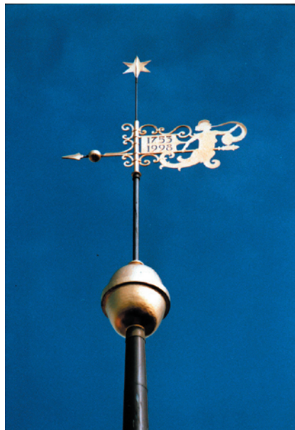
Kirchturmbekrönung in Machern Kugeldurchmesser: 1,10 Meter, Gesamthöhe: 6 Meter
