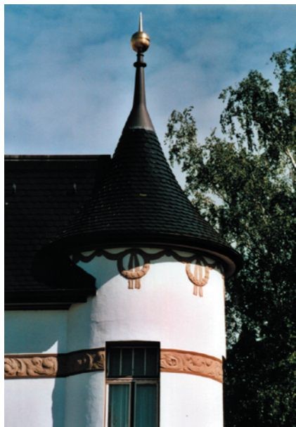
Wohnhaus in Wurzen Nach historischem Vorbild wurde dieser Turmknauf gebaut, vergoldet und genau an das Dach angepasst
