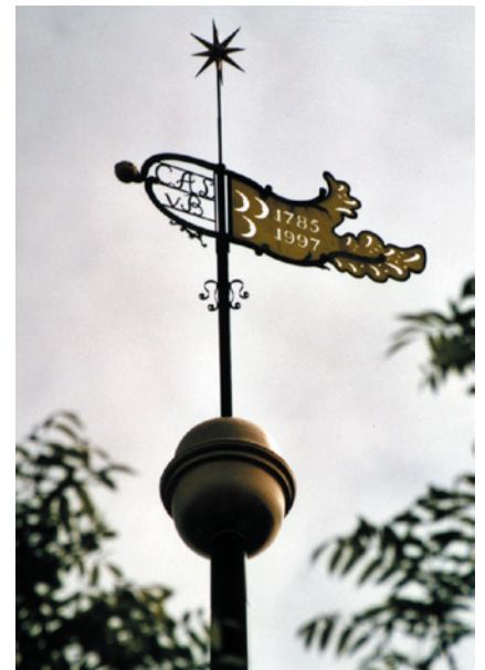
Kirchturmbekrönung in Gerichshain Barocke Wetterfahne Gewicht der Wetterfahne: 90 kg Länge der Wetterfahne: 2,50 Meter
