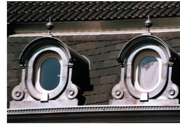
Geschäftshaus in Wurzen Anfertigung der Gaubenverkleidung aus Zink mit Montage
