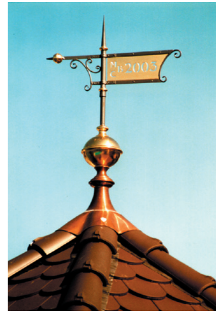
Gartenpavillion bei Wurzen Gehobene Ausführung einer Wetterfahne mit Kugel, Schaft und Anpassung nach örtlichen Gegebenheiten
