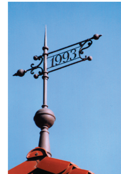
Villa in Wurzen Herstellung der Wetterfahne komplett aus Kupfer, Halterungsstange aus Edelstahl rostfrei
