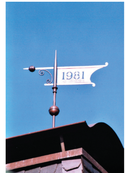
Kaminhaube in Roitzsch Dient zur Abdeckung des Schornsteins vor Nässe, als besonderer Schmuck mit Wetterfahne verziert
