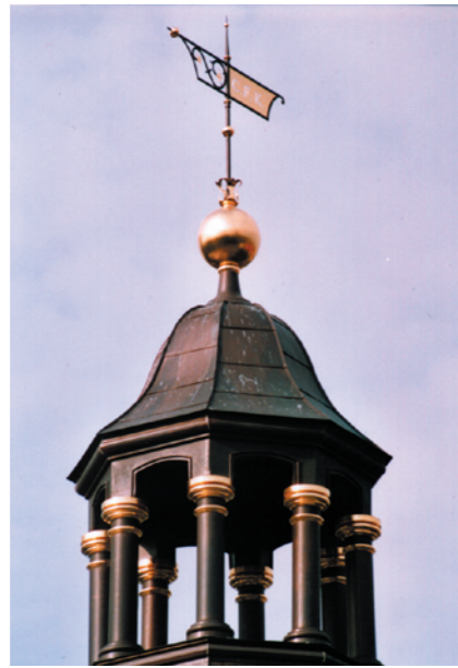
Herrenhaus in Voigtshain Kompletter Entwurf des Turmes. Herstellung der Säulenbasen, Aufbau und Vergoldung der Kapitelle
