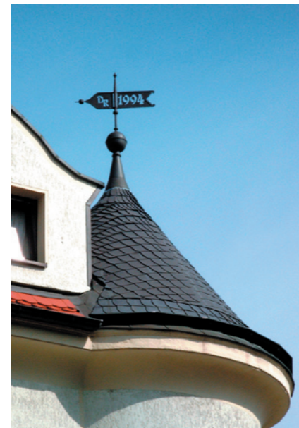
Wohnhaus in Wurzen Einfache Ausführung einer Wetterfahne mit Kugel und Schaft, Anpassung durch Walzblei ans Dach
