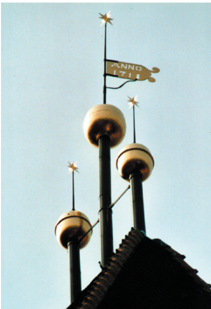
Kirchturmbekrönung in Luckau Restaurierung und Neuanfertigung nach historischen Fragmenten, kom- plette Kranmontage
